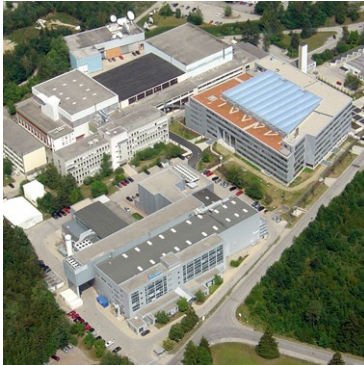
Testzentrum in Ottobrunn
